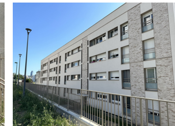
TRAVAUX: EPAISSISSEMENT DE LA FACADE - CREATION DE BALCONS
