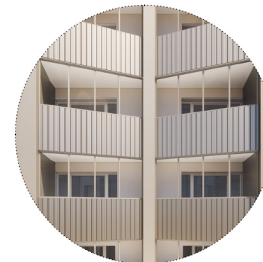
Enduit sur isolant en façade et fond de balcon Mise en peinture des murs et sous-face Fermeture des loggias par vitrage avec allèges pleines HT 110cm + habillage Arrier avec Style'Inov RAL 7032
