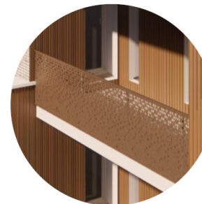
TRAITEMENT DES BALCONS Mailles métalliques perforées
