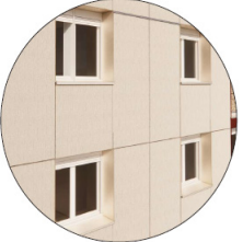
BARDAGE ROCKPANEL STONES SANDY BEIGE Encadrement de baie en aluminium RAL 9001
