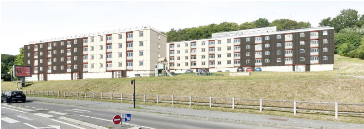
BARDAGE ZINC LAQUE POSE À JOINT DEBOUT VM ZINC TEINTE RAL 7022 Encadrement de baie en aluminium RAL 9001
