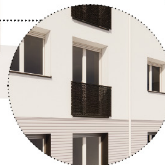
GARDE-CORPS SUR PORTE-FENÊTRES Garde-corps en applique
